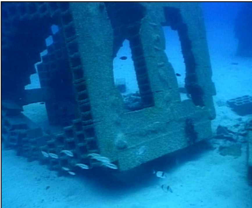
Foto 1.3. Modulo de producción del arrecife de Arrieta, en el que se puede apreciar la base del mismo.
