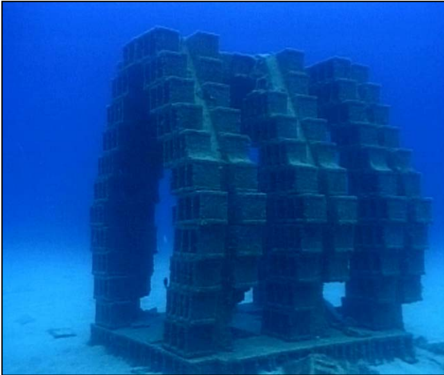
Foto 1.2. Modulo de producción de tipo alveolar del arrecife artificial de Arrieta.
