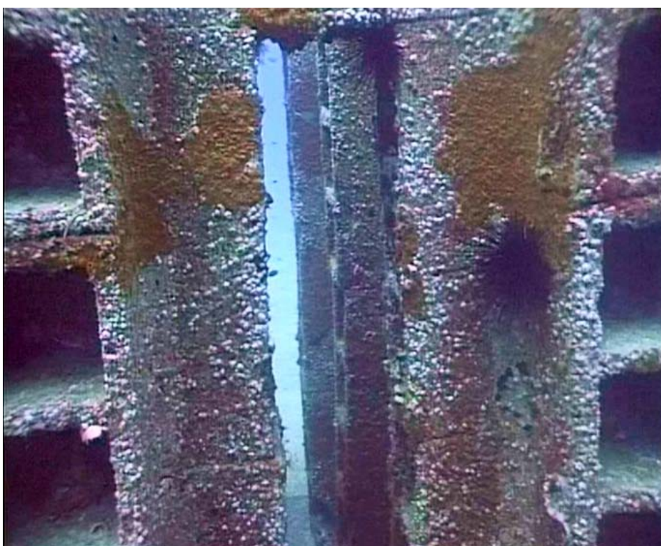
Foto 3.17. Los cráteres formados por las conchas de los cirrípedos (sacabocados) cubren casi el 100% de la superficie de los módulos. Las manchas rojas es Barzella inops .
