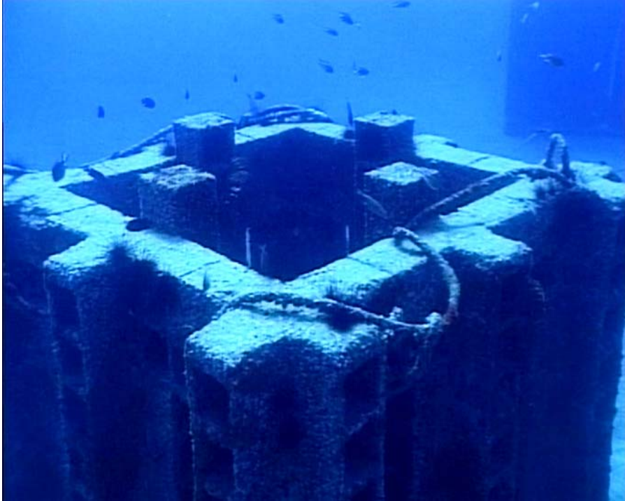
Foto 3.2. Detalle de la parte superior de un módulo. Se pueden observar los cables de acero utilizados para instalar las estructuras.
