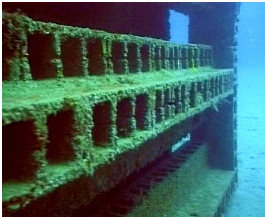
Foto 4.3. Los módulos se han construido utilizando como unidad básica bloque prefabricados de 20 cm. de grosor que han sido fijados con hormigón.
