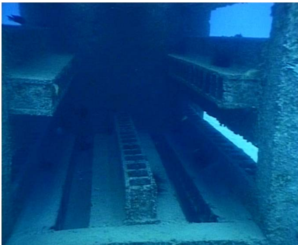
Foto 4.5. Vista del interior de un módulo. Se aprecian como la distribución de los bloques prefabricados está diseñada para que actúen a modo de columnas.
